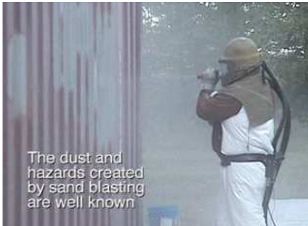
従来工法による施工
