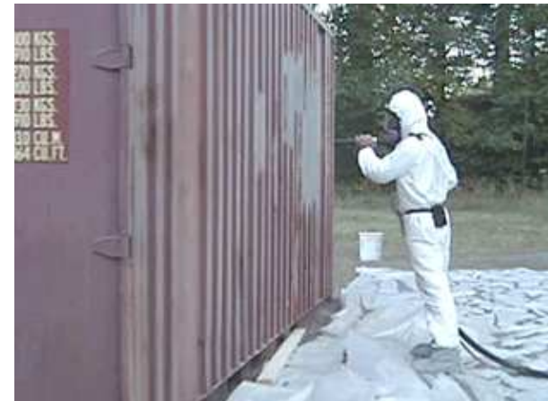
スポンジジェットによる施工
