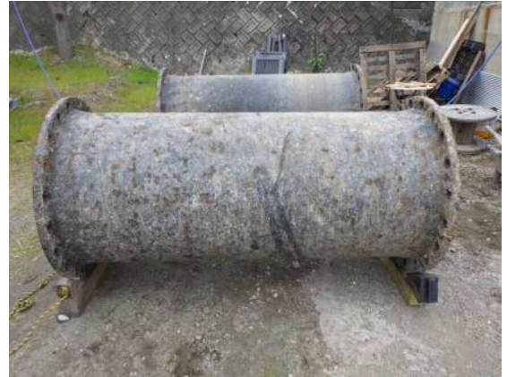
②スポンジブラスト施工
