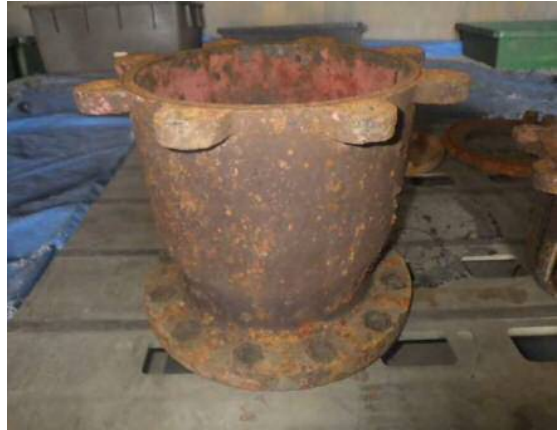
②スポンジブラスト施工
