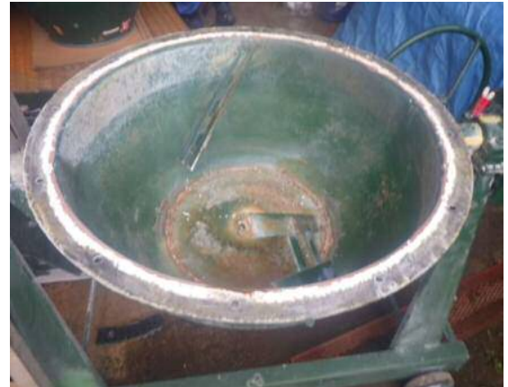
②スポンジブラスト施工
