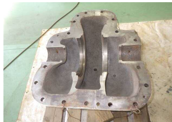
②スポンジブラスト施工
