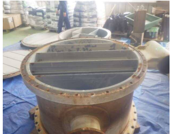
②スポンジブラスト施工
