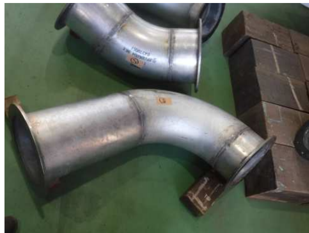
②スポンジブラスト施工
